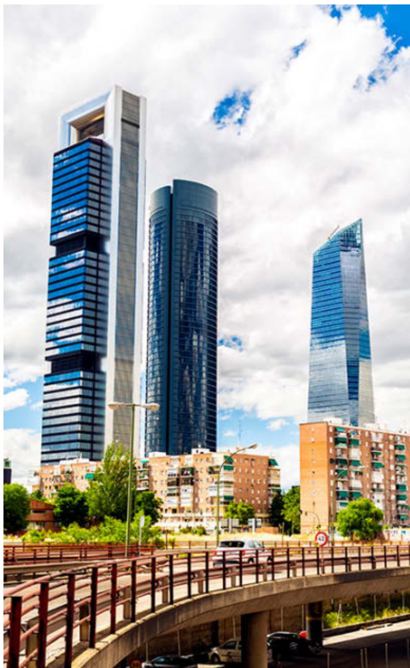
Las cuatro torres de Madrid con un puente delante para la circulación de vehículos.
