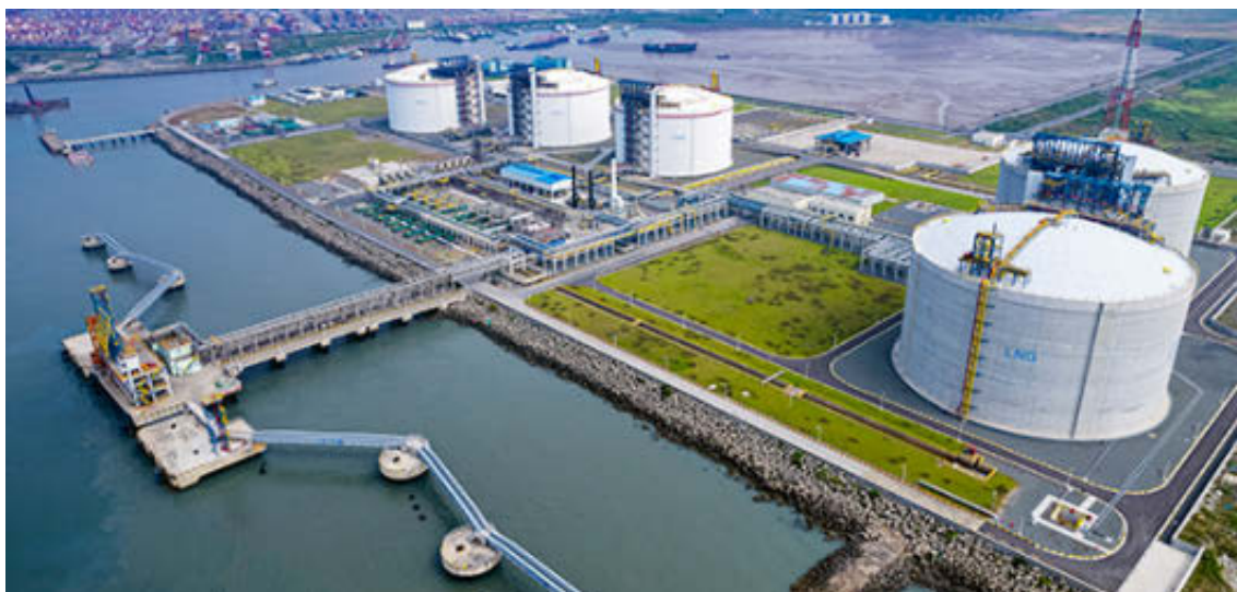
Tanques de GNL en una terminal de regasificación.
